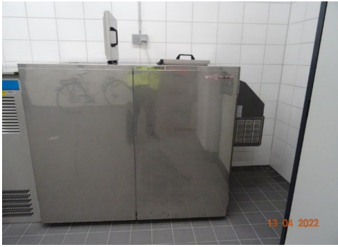
FIGURE 1 Example of waste container: Confiscate cooler in Brandenburg (DE), 240 L, interchangeable container, storage at 5°C and destruction in a waste incineration plant, regular cleaning and disinfection of the container (Courtesy: Landesamt für Ländliche Entwicklung, Landwirtschaft und Flurneuordnung (LELF), Ref. 34).
